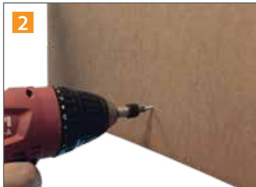
2 Inserire un tassello in nylon  $\varnothing$  6 mm ed una vite.
